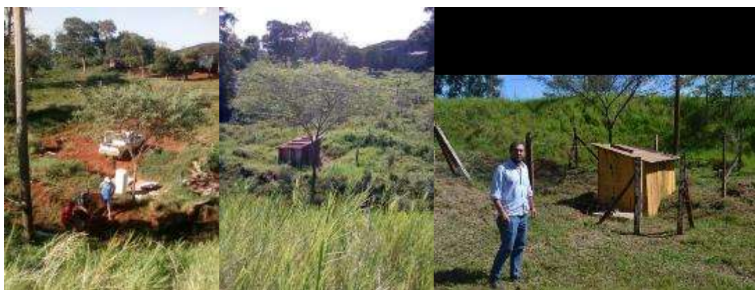
Imagen 2. Proceso de instalación del sistema de bombeo y cercado perimetral de la fuente de agua. Fotografías: Francisco Pascual y Mauricio Alves Do Porto.
