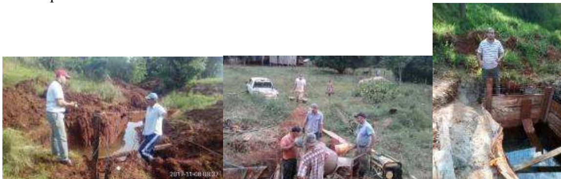
Imagen 1. Vista de los trabajos realizados sobre la vertiente a ser protegida, San Vicente, Misiones. Fotografías: Francisco Pascual y Mauricio Alves Do Porto.
